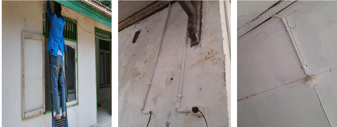
a. Proses instalasi b. Pemasangan proteksi c. Penggantian komponen
