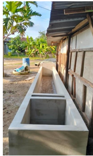
Gambar 3. Bak penampungan digester pada media plastik PE untuk feses sapi
