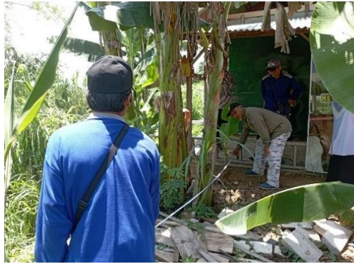
Gambar 4. Pengukuran lahan instalasi biodigester
