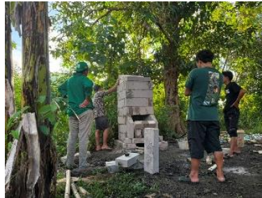
Gambar 1. Proses Pembuatan Insinerator Sederhana Ramah Lingkungan
